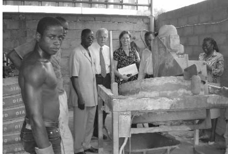
Fabrication des pavés vibrés à MAVICO
